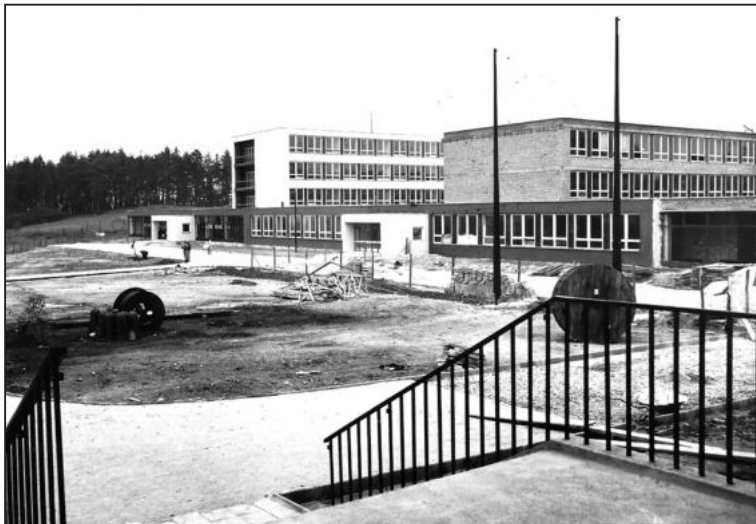
TĚSNĚ před dokončením stavby způsobili mladí výtržníci na sídlišti poprask. Rozbili 50 oken novostavby, které byly vytvořeny na zakázku pro jihlavské školy.
